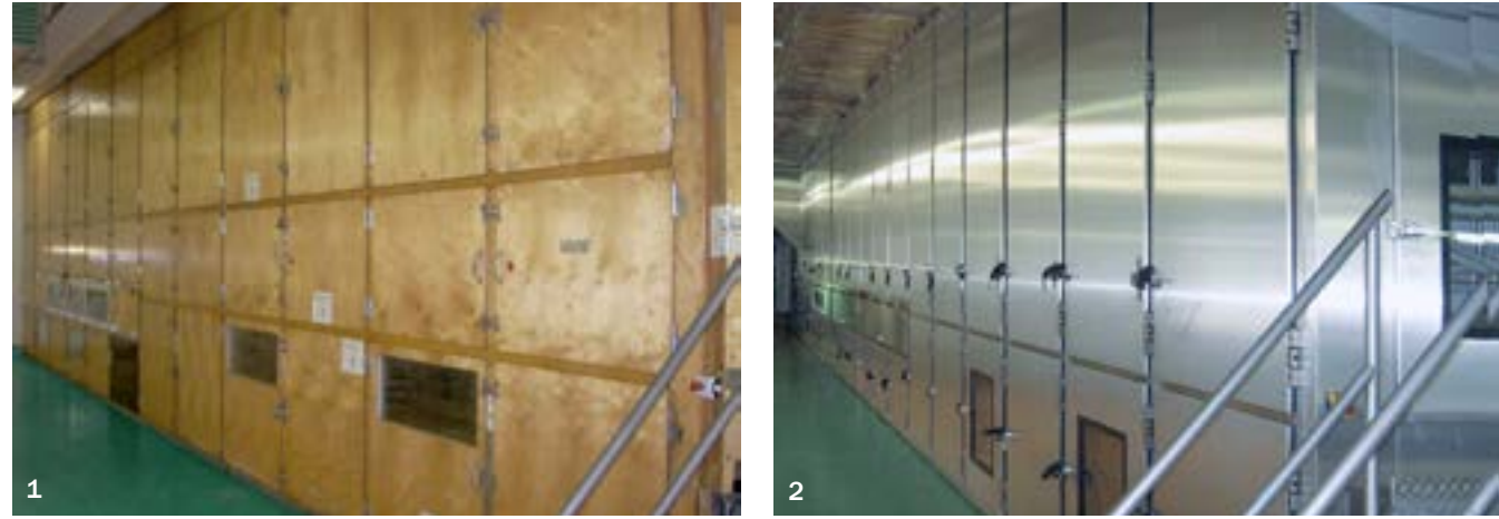
Die Anlagen der Schokoladenproduktion sind solide gebaut und entsprechend langlebig. Umso wichtiger ist dann eine energetische Modernisierung. Aus Alt mach Neu: Im Zuge des Retrofit empfiehlt sich auch eine Erneuerung der kompletten Verkleidung mit dem Ziel höherer Servicefreundlichkeit und verbesserter Hygiene. Das Ergebnis: Die Anlage ist kaum wiederzuerkennen.
